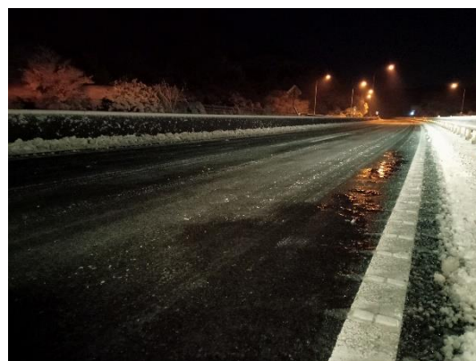
路面凍結状況 (横浜横須賀道路 横須賀IC付近)
